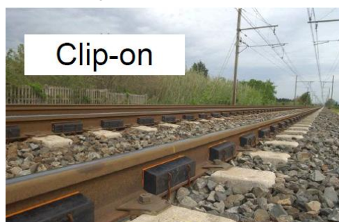
Figura nr 4: Amortizor de zgomot CORUS, aplicat
